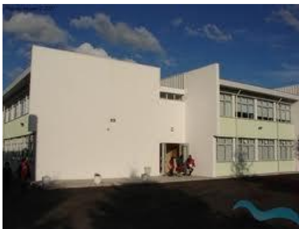
Fig. 2 – Escola EB2,3/S Dr. Bento da Cruz – Edifício do 2.º ciclo 6
