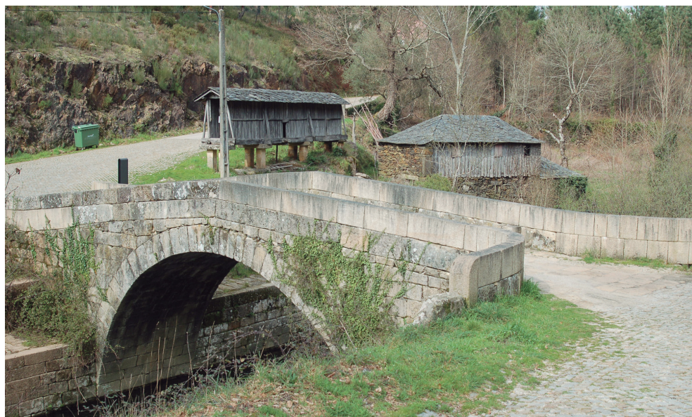
Figura 4 - Ponte sobre o rio Olo, no lugar da Várzea
