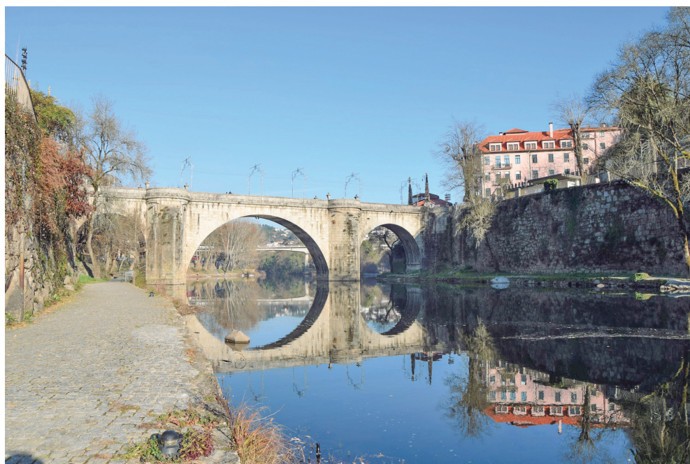
Figura 5. A actual Ponte de Amarante/Ponte de São Gonçalo.
