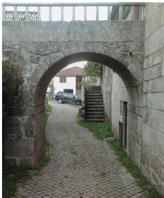
Figura 8 – O Arco de Arrabães está situado próximo do lugar da Torre e está integrado na estrutura de acesso ao primeiro piso de uma casa datada de 1716. De acordo com a lenda da princesa Ximena, contada nas Memórias Paroquiais, foi aqui que o rei Ordonho II caçou o javali que perseguiu desde a Campeã.
