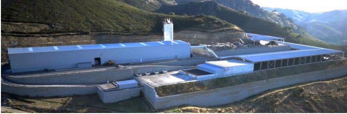
Figura 8 - Vista panorâmica da UTMB de Urjais Fonte: RN, 2014.
