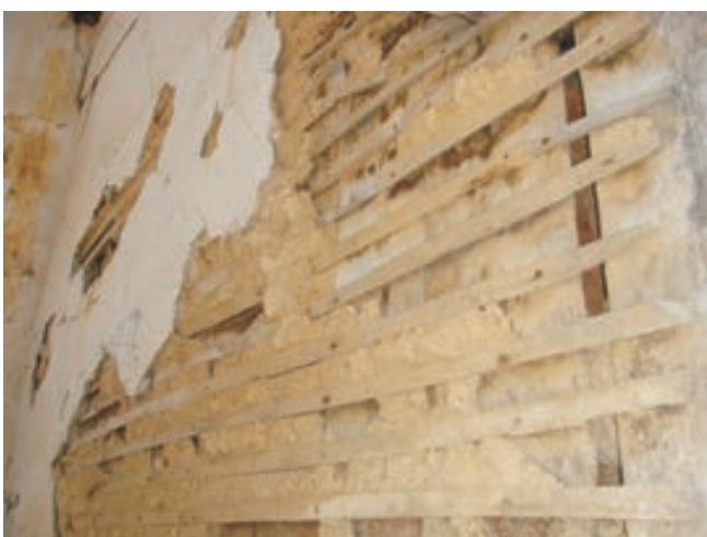
Estrutura do tabique
