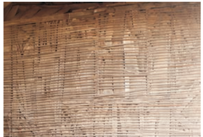
Estrutura em tabique utilizada no último piso do edifício.
