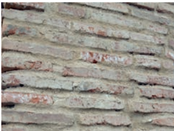
Aspetto da tijoleira das abóbadas
