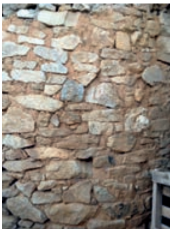
Alvenaria de pedra de granito com argamassa de assentamento
