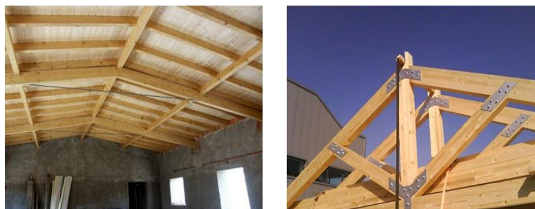
Figura A27: Cobertura em madeira, [50].
