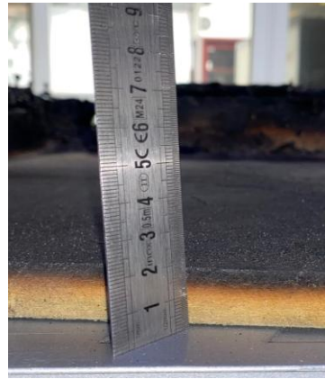
Figura 54. Medição da espessura carbonizada do MDF interno.
