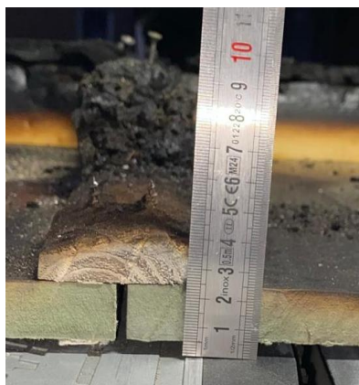
Figura 51. Medição da profundidade de carbonização no montante central.
