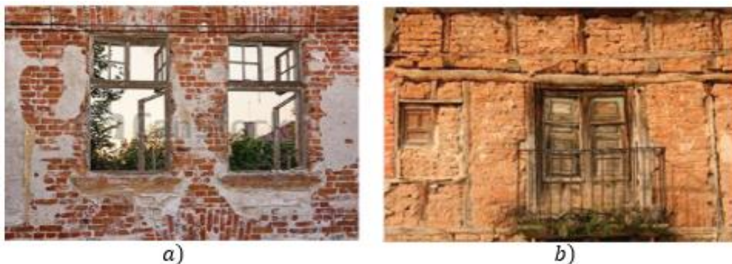
Figura 1– Construções antigas em tijolo: a) alvenaria em tijolo; b) alvenaria em tijolo e estrutura em madeira. Fonte: Imagens retiradas do Google.
