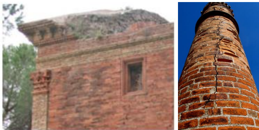
Figura 4 - Construção antiga em tijolo maciço. Fonte: Imagens retiradas do Google.
