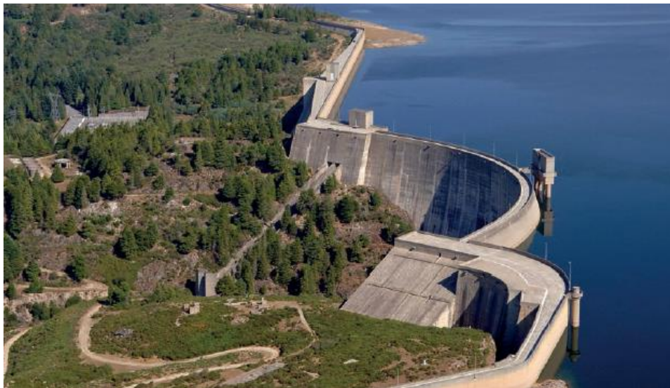
Figura 2.7 – Aproveitamento hidroelétrico de albufeira, Alto Rabagão [7]
