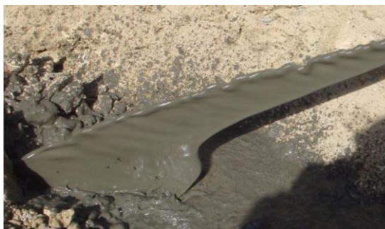
Figura 4 - Calda de cimento. (Antunes, 2012)
