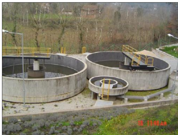
Figura 24 - Decantadores secundários e caixa de distribuição - ETAR de Celorico de Basto
