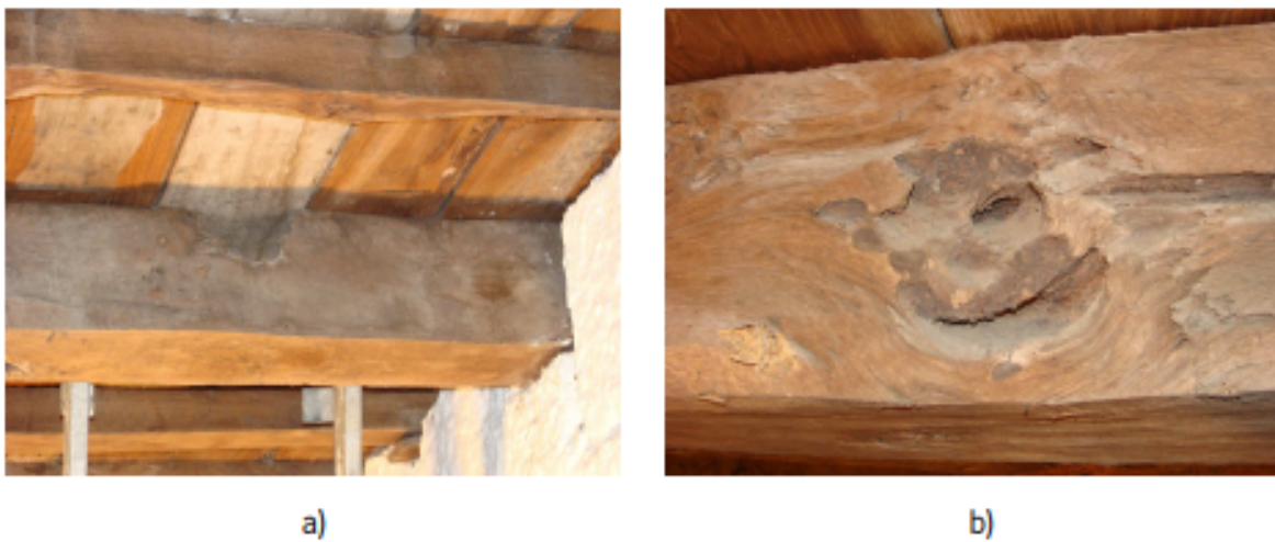
Figura 2.6: Identificação de defeitos da madeira: a) falha de seção; b) nós, [12].
