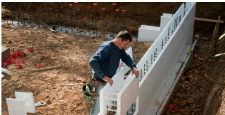
Figura 2.8: Montagem de blocos ICF's
