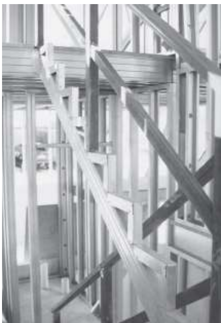
Figura 3.31: Escada tipo viga inclinada [11].
