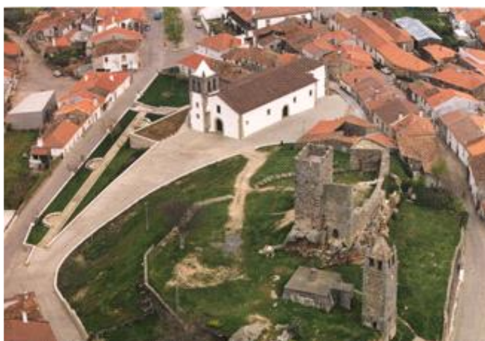
Ilustração 37 - Vista aérea do Castelo de Mogadouro 32
