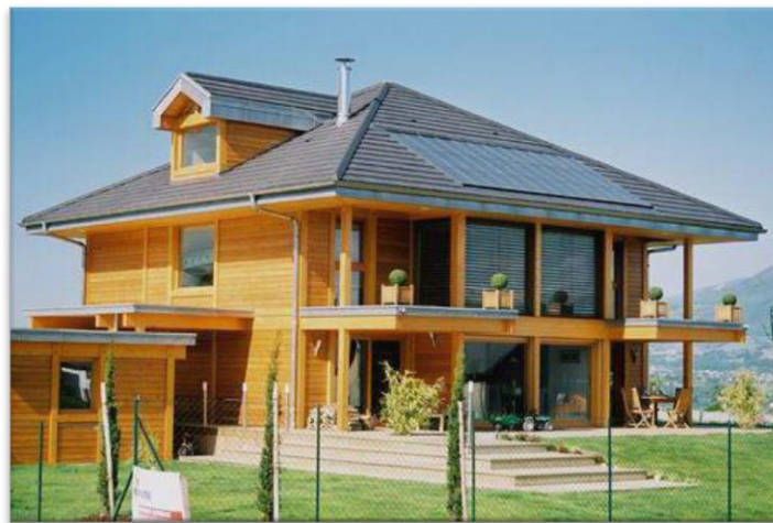
Figura 7- Construção em madeira, [10].
