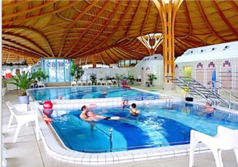
Figura 8- Coberturas em ambientes agressivos.
