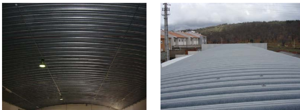
a) Interior da cobertura do armazém.
