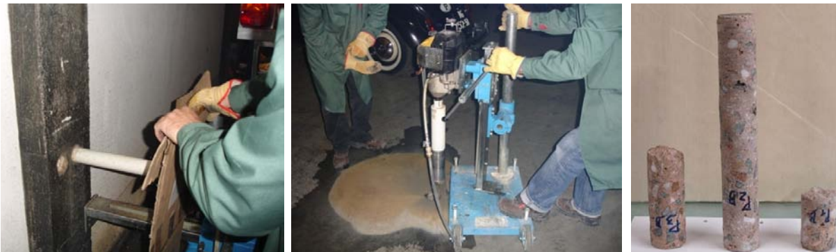
Figura 8: Extração de carotes nos pilares e laje.
