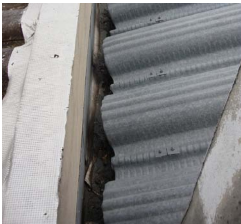
a) Fixação da cobertura aos apoios.
