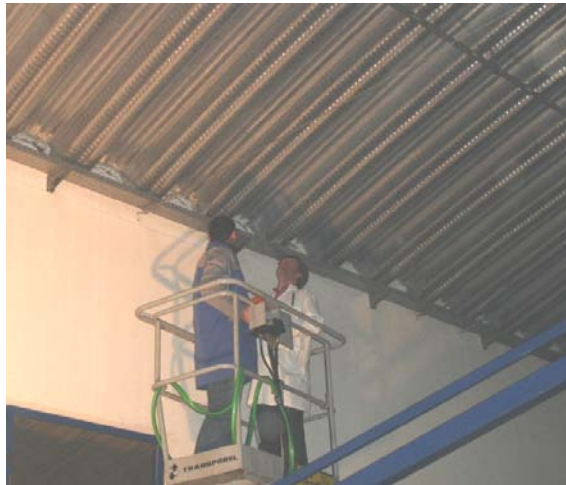
Figura 4: Inspeção visual à cobertura e apoios.
