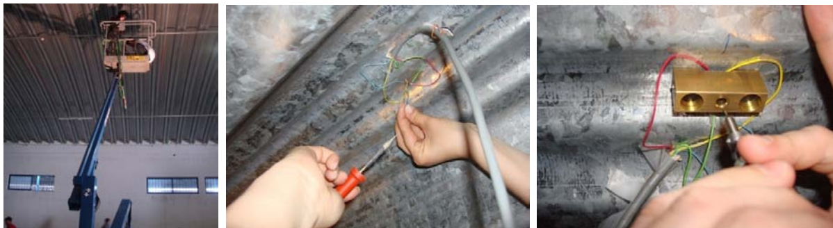
Figura 2: Medição de tensões instaladas na cobertura.
