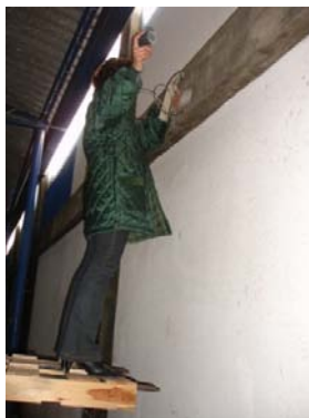
Figura 7: Medições efectuadas com o detector de armaduras.
