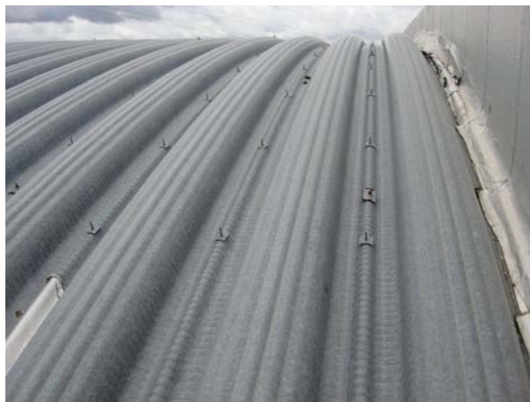
b) Fixação da cobertura entre cascas metálicas.
