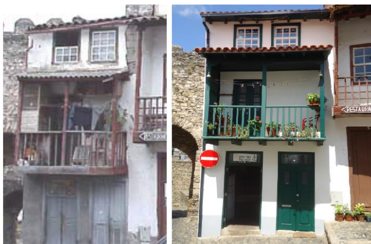
Figura 18 Um dos edifícios da cidadela, antes e depois da intervenção do “Programa de Incentivos à Recuperação de Fachadas e Coberturas de Imóveis Degradados situados na Cidadela de Bragança”.
