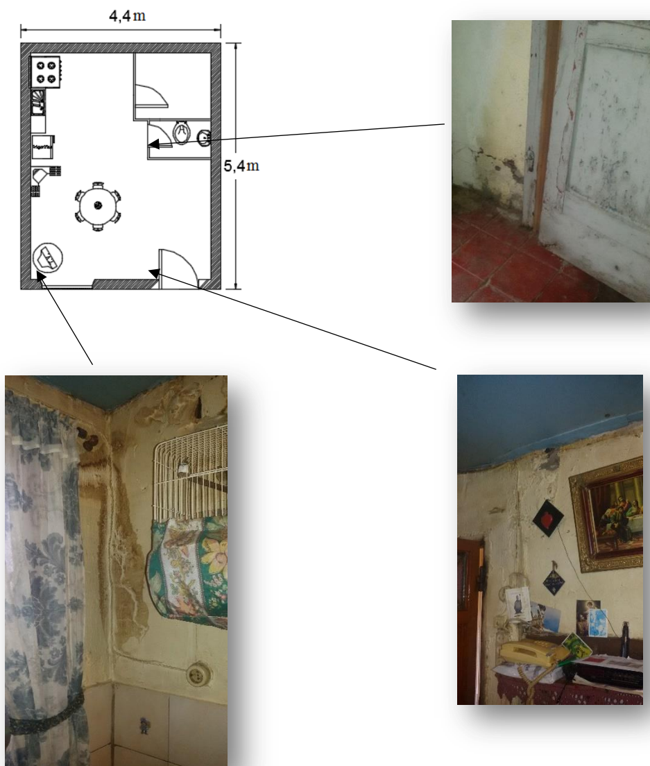
Figura 0-6. Plantas do edifício (Caso 3) e registo fotográfico das anomalias
