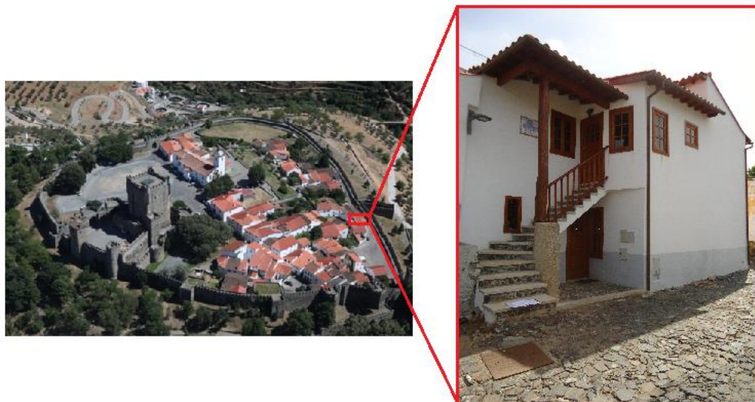
Figura 38 Fotografia aérea do edifício em estudo e fachada.
