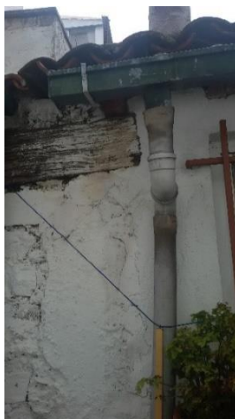
Figura 0-7 Condições da envolvente exterior
