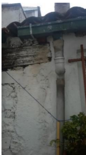
Figura 35 Condições da envolvente exterior.
