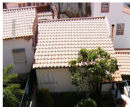
Figura 23 Casas com cobertura em telha cerâmica.
