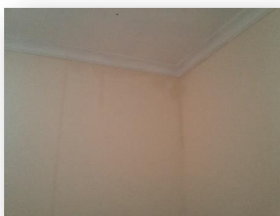
Figura 0-11. Plantas do edifício (Caso 5) e registo fotográfico das anomalias
