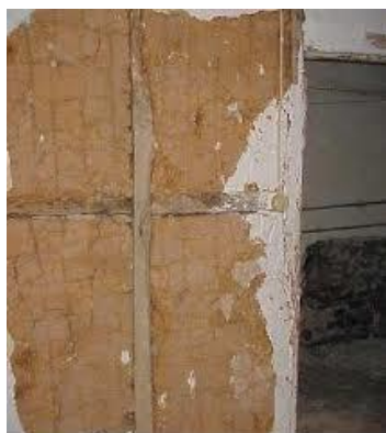
Figura 22 Parede de tabique.
