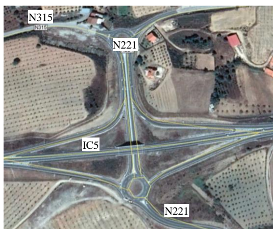
Figura 6.1 a) – Cruzamento EN 221 com a EN 315 km 56+600 (f.d) e km 56+700 (f.e)
