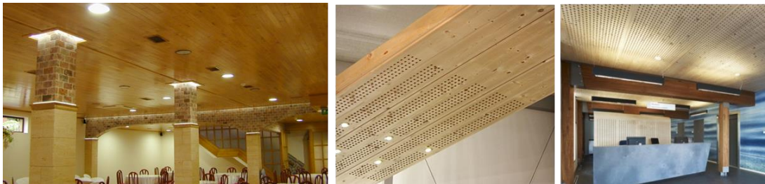
Figura 30 - Utilização de lajes celulares no quotidiano.
