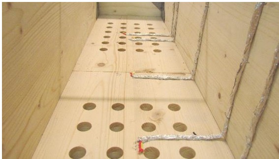
Figura 52 - Colocação do fio termopar na placa de teto, LTM.
