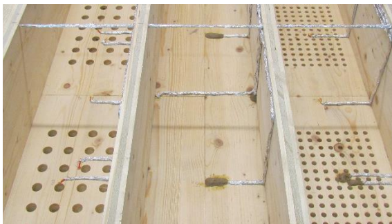
Figura 59 - Colocação dos termopares na placa de teto, LTM.
