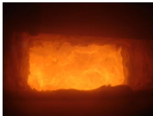
Figura 75 - Janela do forno, fogo localizado no teto do forno, Laje 1, LERM.
