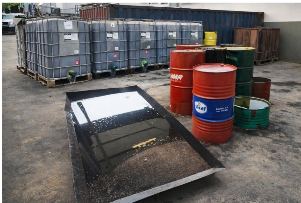
Figura 10: Área de armazenamento de óleos usados da SOGESTER, com aparadeiras de contenção de derrames, reservatórios e tambores metálicos para acondicionamento dos resíduos oleosos gerados na manutenção de máquinas e equipamentos.
