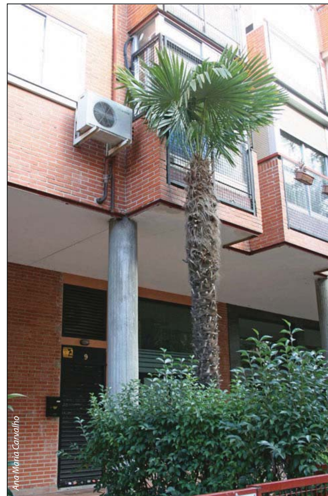
Exemplar arbóreo obstruindo janelas de edifício num bairro residencial em Madrid.
