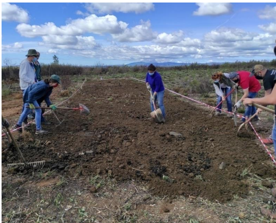
Figura 3 - Espalhamento do Tecnosolo na parcela de estudo.
