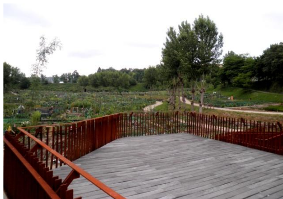
Figura 21: Plataforma da 2ª Fase
