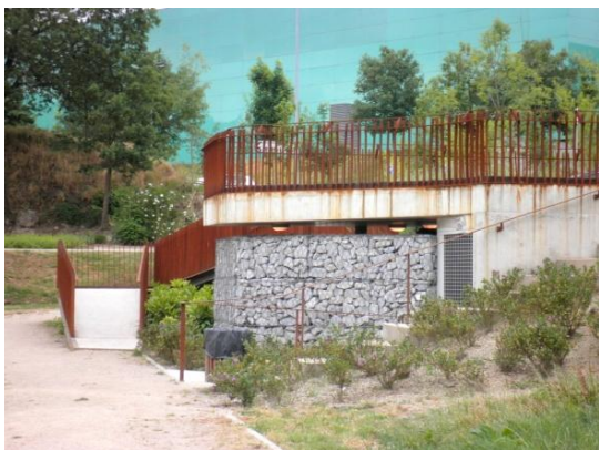
Figura 20: Acesso Pedonal à 2ª Fase
