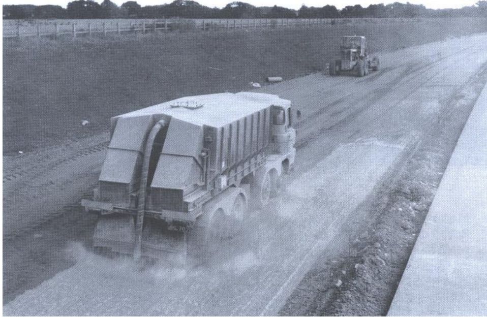
Figura 2.19 - Espalhamento por um camião de cal em calda (Sherwood, 1995).
