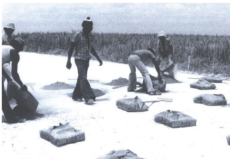
Figura 3.3 - Espalhamento manual do cimento (Sherwood, 1995).
