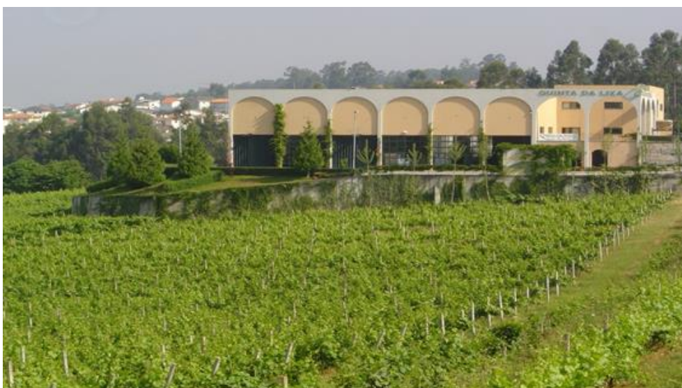
Figura 1 – Vista parcial das instalações da adega da Quinta da Lixa.
