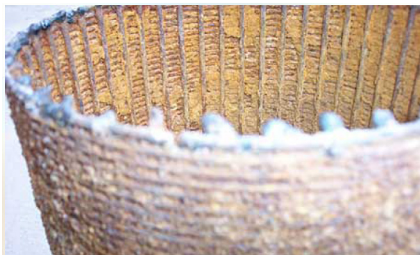
Figura 4: Exemplo de uma zona de ralos completamente colmatada por incrustação com minerais
