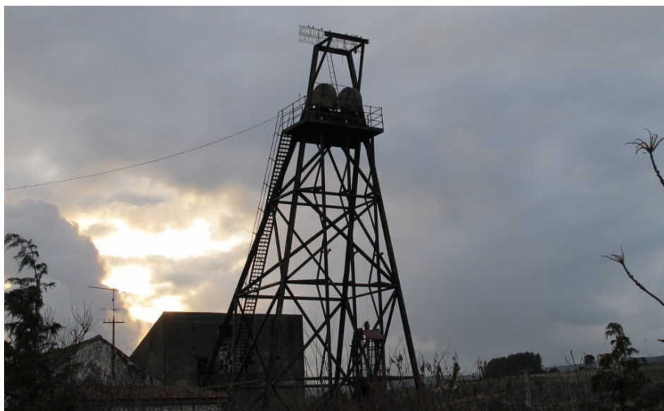
Figura 3: Estrutura do elevador principal das antigas Minas de Jales.
