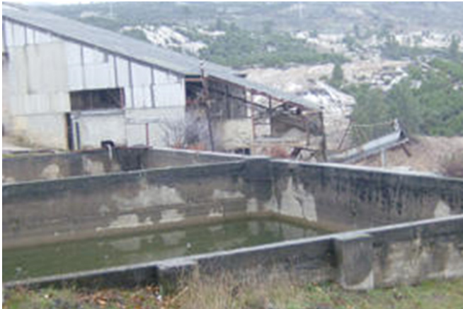
Figura 5: Vista das antigas instalações mineiras da Mina de Vale das Gatas. (Fonte: https://www.avozdetrasosmontes.pt/noticia/1735 ).
