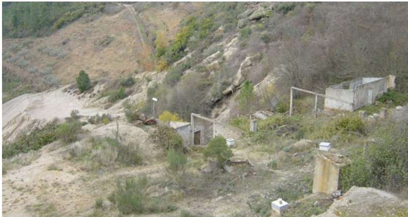
Figura 7: Vista das antigas instalações mineiras da Mina de Murçós. (Fonte: https://edm.pt/projetos/recuperacao-ambiental-da-area-mineira-de-murcos/ ).
