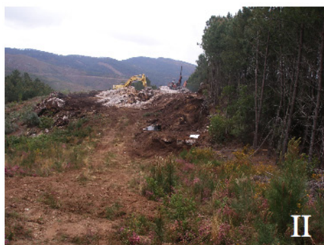
29/04/2009 – decapagem inicial e furação
