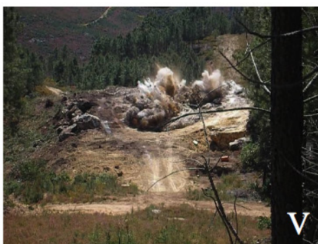
05/05/2009 – momento do 1º desmonte a fogo ("rock blasting")
