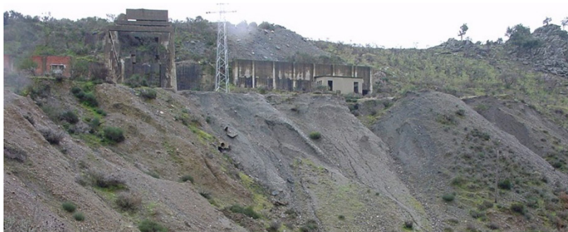
Figura 4: Vista das antigas instalações mineiras da Mina de Fonte Santa.
