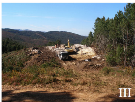
04/05/2009 – exploração superficial com "ripper" - início da extração e furação
