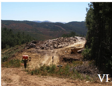
05/05/2009 – após o 1º desmonte a fogo
