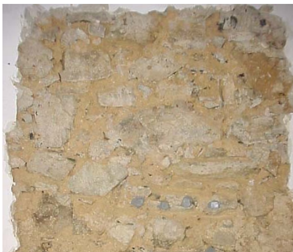
Figura 5.22 - Aspecto da alvenaria na janela 3 (1º andar).
