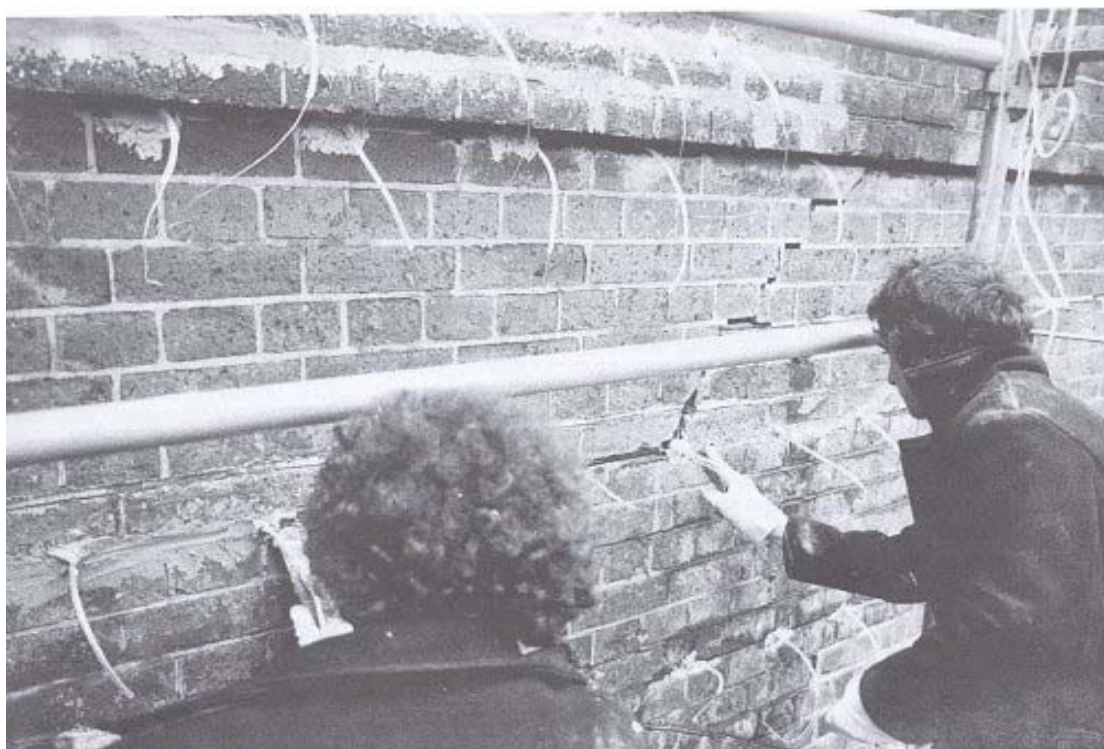
Figura 3.4 – Preparação de uma parede de alvenaria para injeção. Selagem de juntas e fendas e colocação dos tubos de injeção [Hill, 1995].
