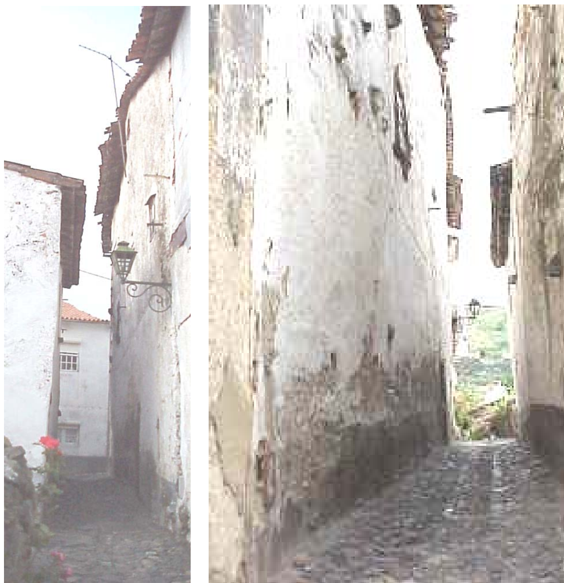
Figura 5.3 - Aspecto da parede de empena - alçado lateral - na rua Duque D. Teodósio I.
