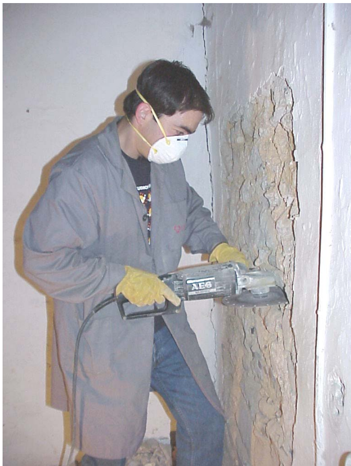
Figura 5.32 - Operação de abertura dos rasgos com auxílio de máquina de corte de disco rotativo.
