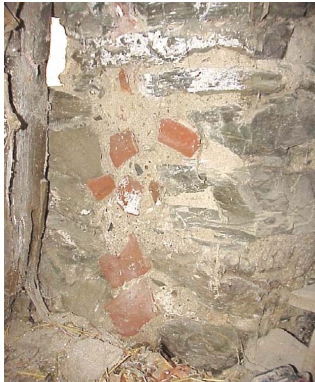
Figura 5.24 - Aspecto da alvenaria na ombreira da porta sem lancis (Fotografia 13).
