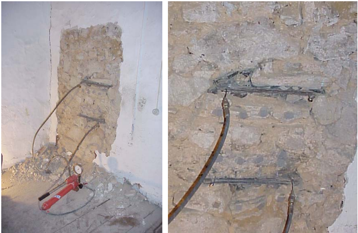
Figura 5.45 - Aspecto das condições do ensaio com macacos planos duplos na janela 3.
