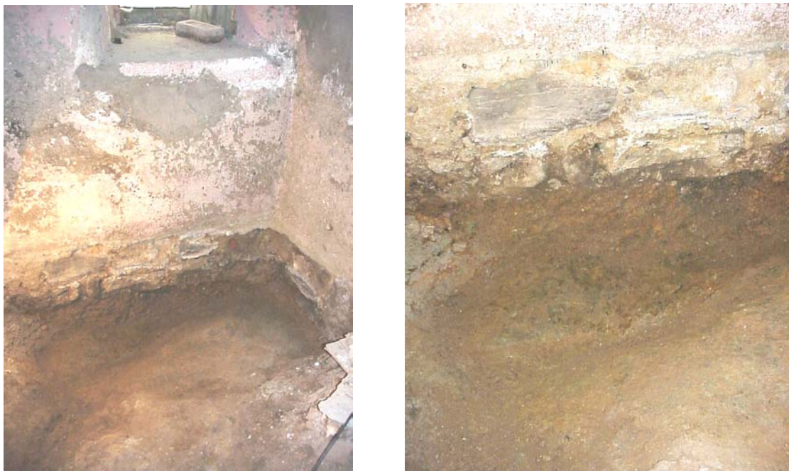
Figura 5.47 - Aspecto do poço, localizado junto à parede de empena sul, para inspecção das fundações (Fotografias 14).
