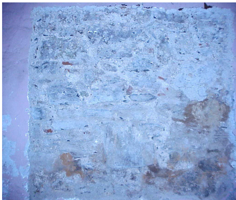
Figura 5.20 - Aspecto da alvenaria na janela 1 (rés-do-chão).
