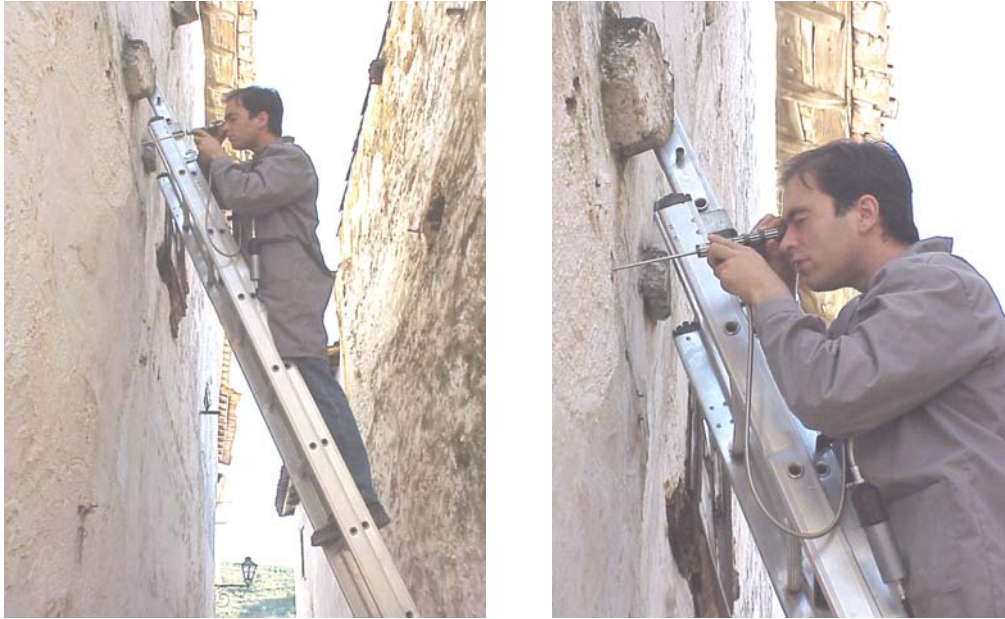
Figura 5.26 - Inspeção com câmara boroscópica pelo exterior.
