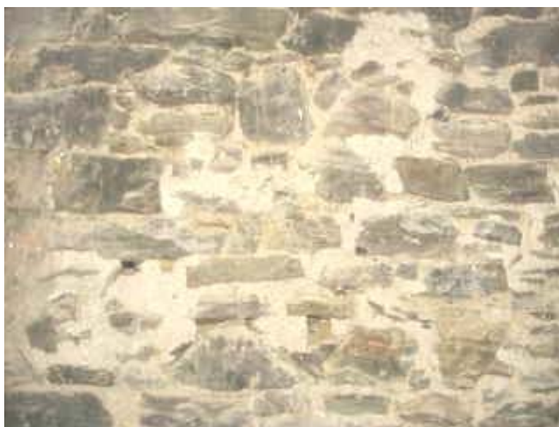
Figura 5.21 - Aspecto da alvenaria na janela 2 (rés-do-chão).
