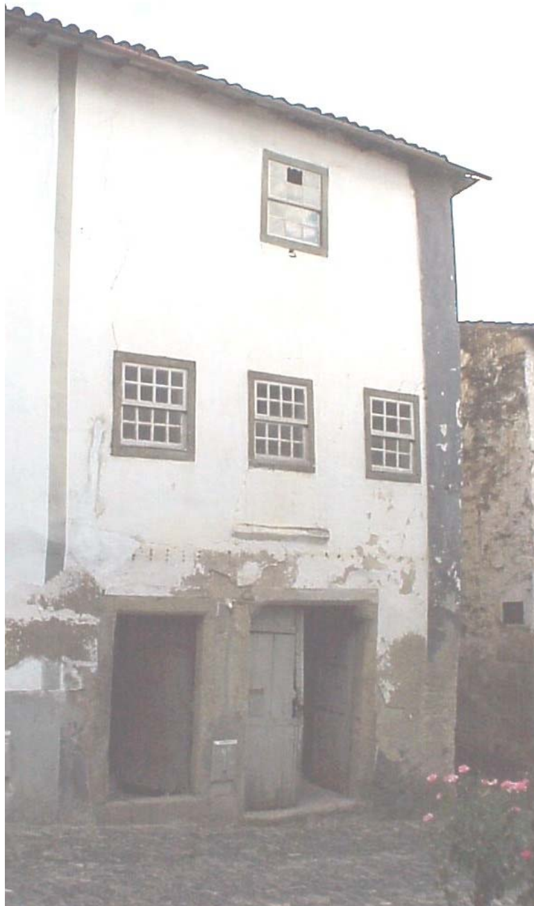
Figura 5.4 - Aspecto da fachada - alçado principal - do edifício.
