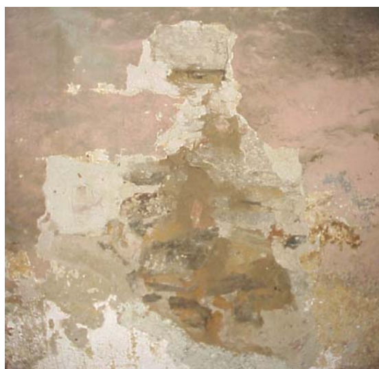
Figura 5.13 - Aspecto do estado de desagregação da parede de empena no rés-do-chão entre os eixos 1 e 2 (fotografia 7).
