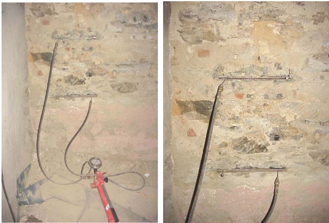
Figura 5.41 - Aspecto das condições do ensaio com macacos planos duplos na janela 1.
