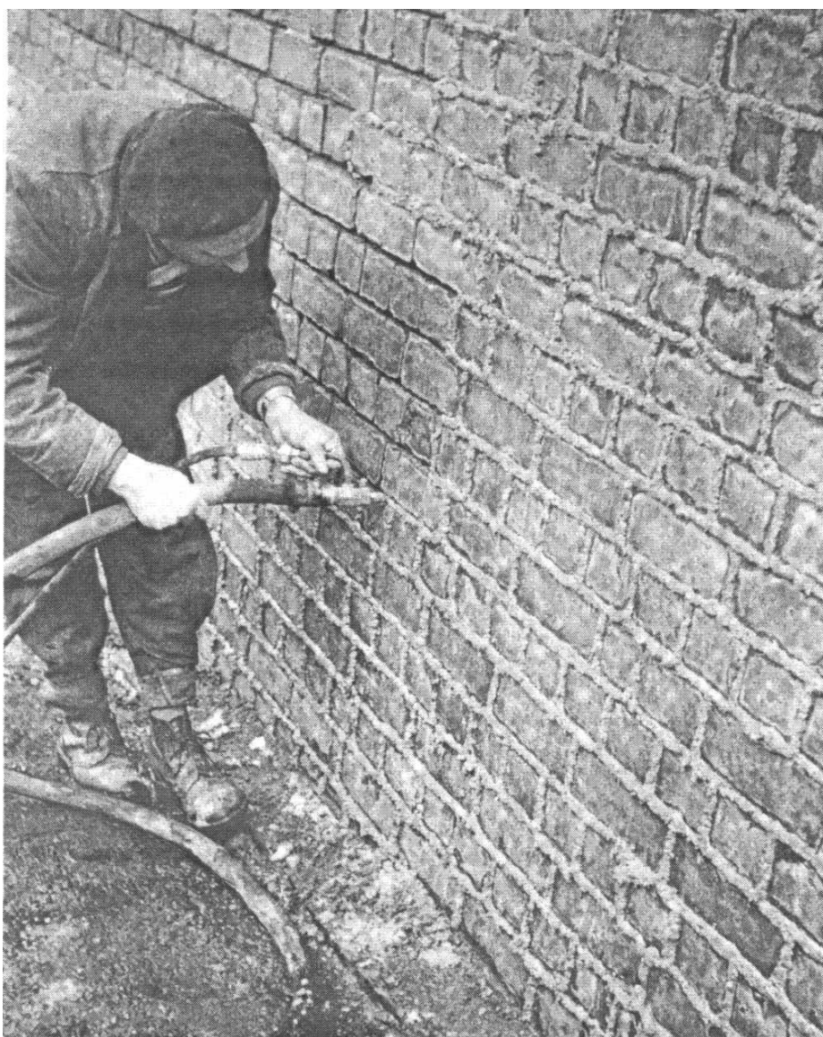
Figura 3.25 - Operação de substituição da argamassa das juntas - refechamento das juntas - numa parede de alvenaria de blocos cerâmicos.
