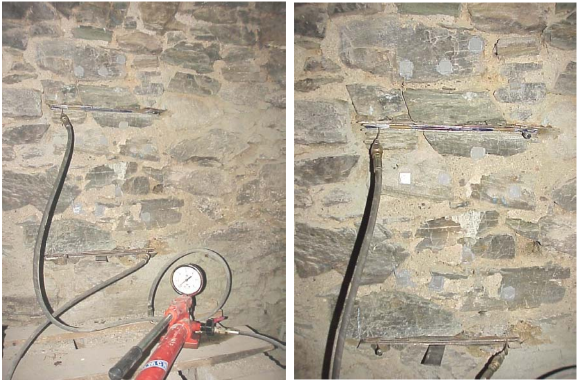
Figura 5.43 - Aspecto das condições do ensaio com macacos planos duplos na janela 2.
