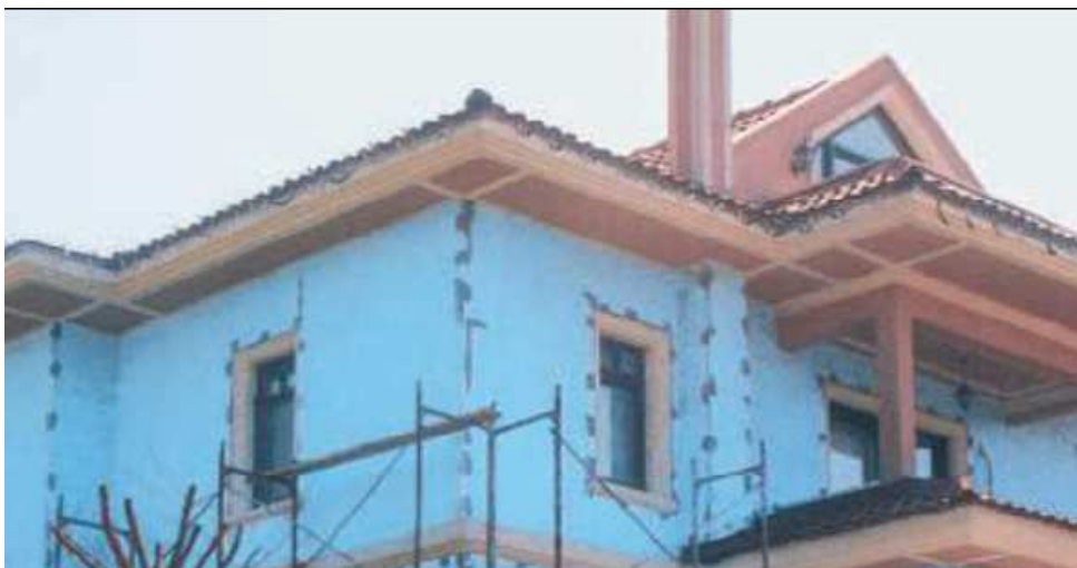
Figura 13 - Isolamento térmico pelo exterior. [16]
