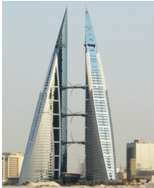
Figura 2.3.8: Sistema de captação e aceleração da torre Bahrain World Trade Center [13].
