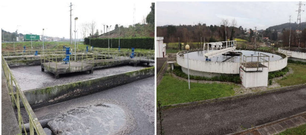
Figura 10 – Tratamento secundário ETAR I
