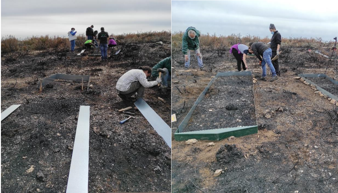
Figura 7 - Instalação de microparcelas de erosão na área experimental
