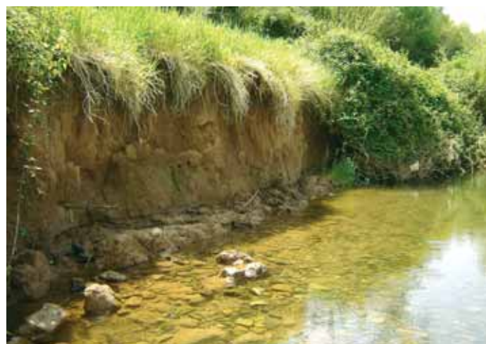
Margens com forte erosão e pouco consolidadas, resultado da eliminação do estrato arbóreo da vegetação ribeirinha (Rio Dueça (MO_014), Bacia do Mondego).
