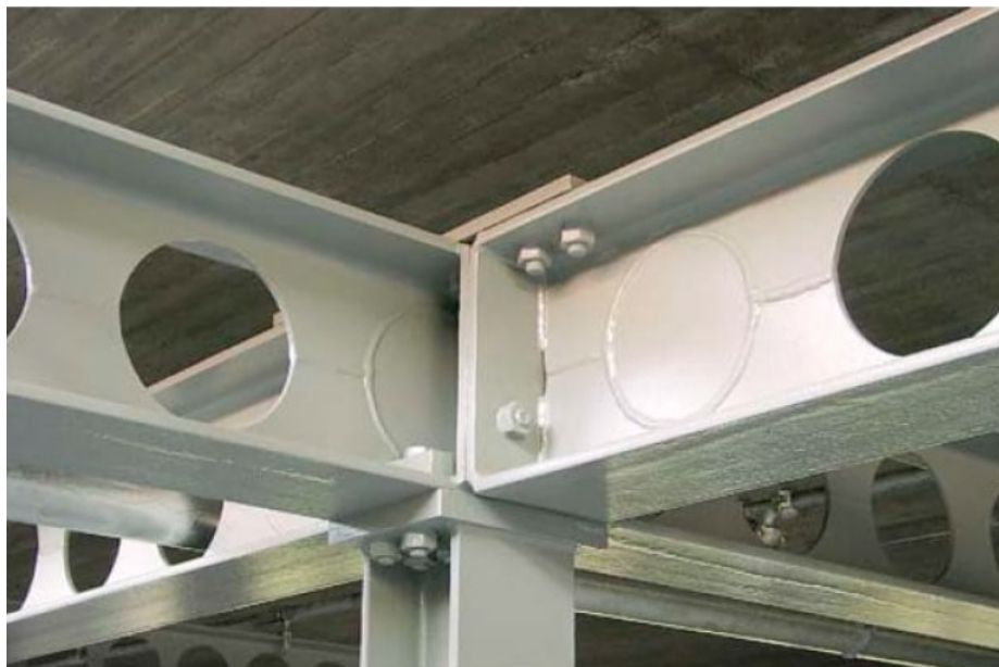
Figura 2.11: Reforço do furo por preenchimento, [25].
