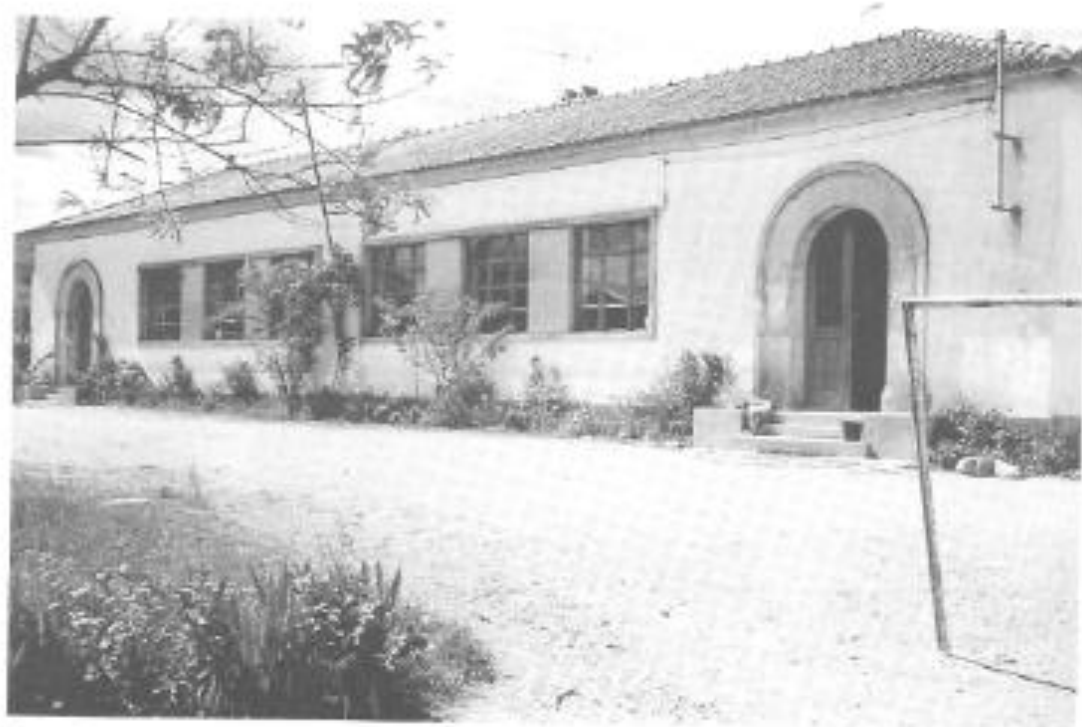
Fotografia 26 e 27 – Escola de Parada, com 4 salas e Escola de Coelhoso, com duas salas. São ambas tipo Plano dos Centenários (Tipo Minho-Granito) construídas antes de 1955.
