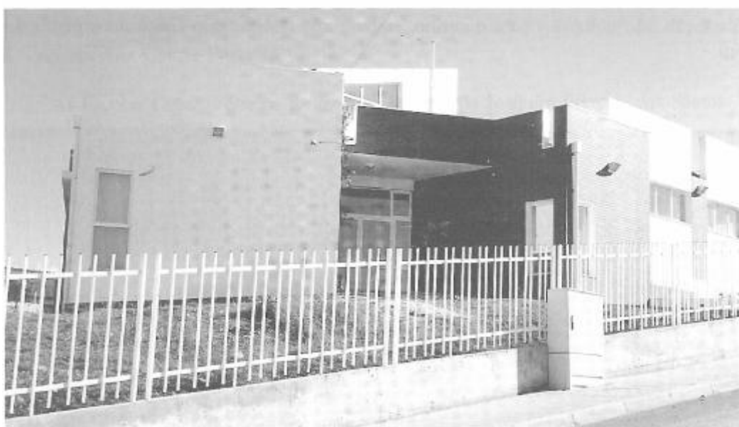
Fotografia 19 e 20 – Escola nº 11 de Bragança, (4 salas), conhecida como Escola do Campo Redondo. Foi construída na década de 80. Tem 4 salas (tendo sido uma delas adaptada para o Ensino Especial, na área da deficiência auditiva) e sala de professores. A Escola nº 11, situada no bairro dos Formarigos, tem (3 salas), apenas duas a funcionar. Inaugurada em Dezembro de 2001.
