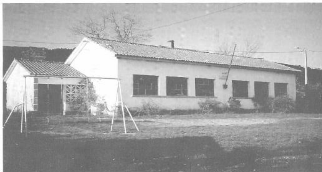
Fotografia 10 e 11 – Escola de Rabal, do concelho de Bragança, que mantém todo o traçado e características originais. Foi construída no ano de 1960, pelo Ministério das Obras Públicas, Direcção Geral do Ensino Primário, conforme consta da placa afixada na parte central do edifício.
