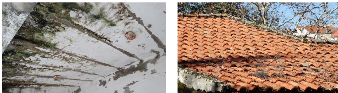
Figura 17 – (a) Aspeto da laje de teto inclinada onde são perceptíveis as vigotas pré-esforçadas, (b) Aspeto da cobertura em telha cerâmica
