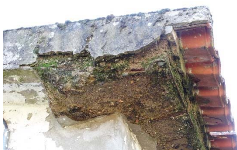
Figura 22 – Aspeto das cornijas do edifício, com destacamento do betão e armaduras à vista
