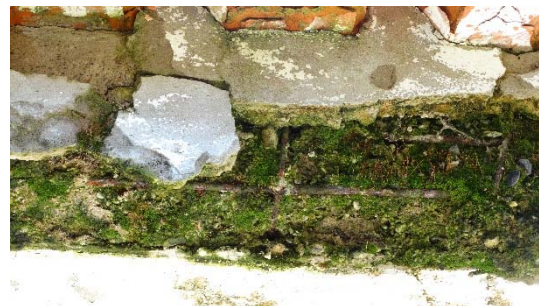
Figura 22 – Aspeto das cornijas do edifício, com destacamento do betão e armaduras à vista
