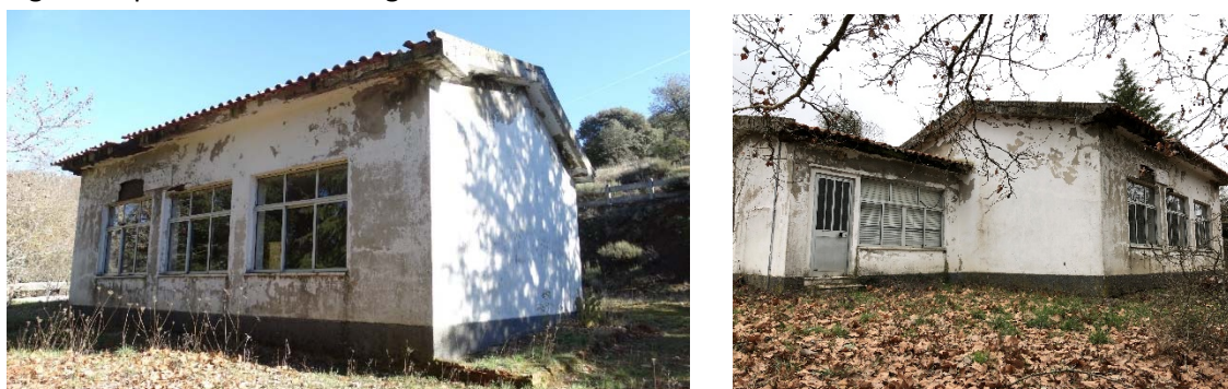
Figura 2 – Aspeto da fachada principal do edifício - Oeste
