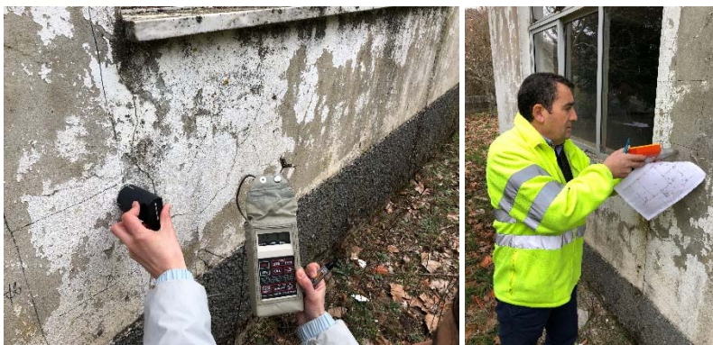
Figura 12 – Inspeção com detetor de armaduras
