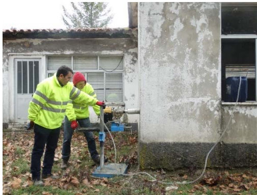
Figura 14 - Extração de uma carote no pilar P 1
