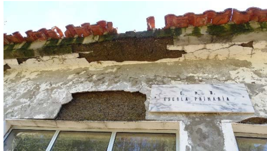
Figura 20 – (a) Medição qualitativa de humidade com humidímetro, (b) Destacamento de rebocos e betão
