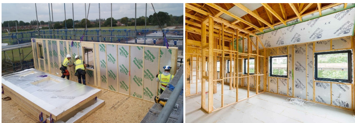
Figura 7 - Painéis estruturas de madeira em obra em fase de montagem
