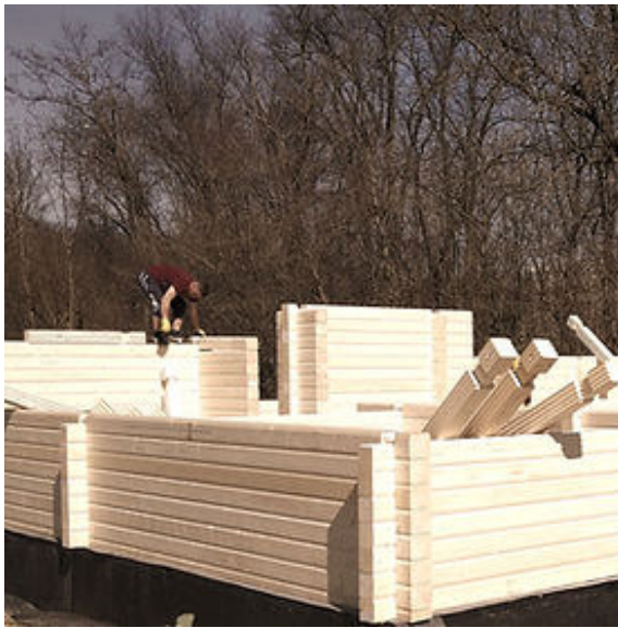
Figura 3 - Fase de construção com encaixe de meia madeira
