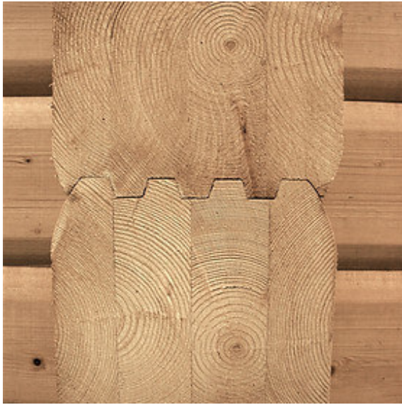
Figura 2 - Perfil tronco madeira lamelada colada
