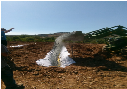
Figura 2.1. Aplicação de tubagem geodreno perfurada e manta geotêxtil em amendoal.
