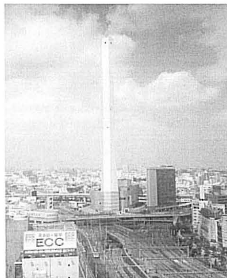
Figura 7 – A incineradora de Toshima.
