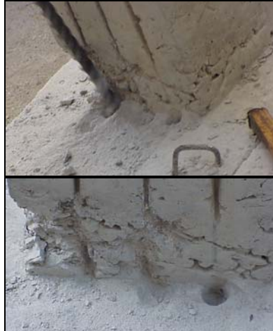
Figura 4 - Abertura dos buracos de fixação dos laminados à sapata.
