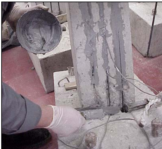
Figura 6 - Fixação dos laminados a um elemento de pilar.
