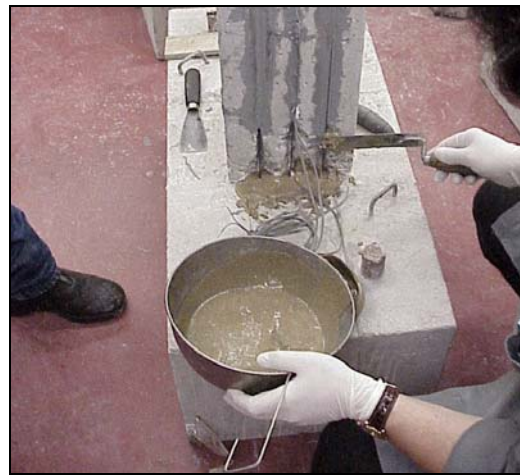
Figura 7 - Aplicação da argamassa epóxida nos buracos de fixação dos laminados à sapata.
