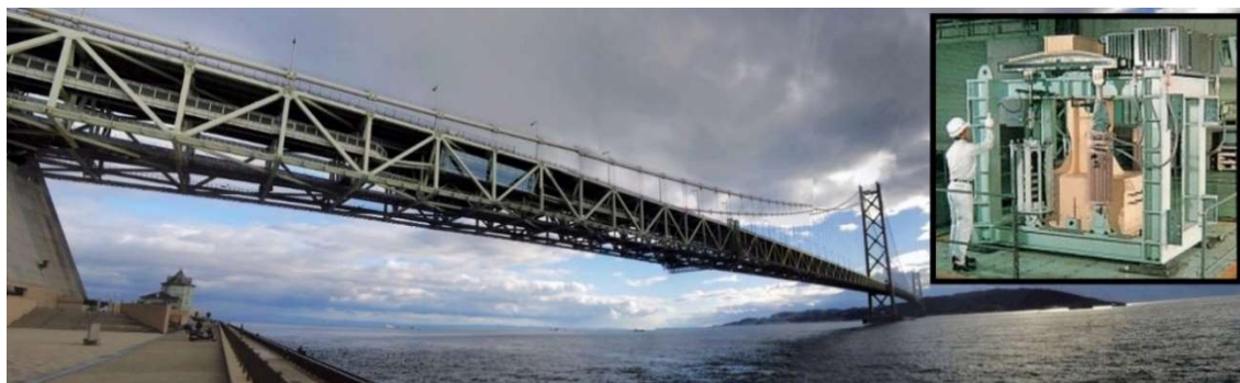
Figura 2.24 – Ponte Akashi Kaikyo com pormenor do TMD.
