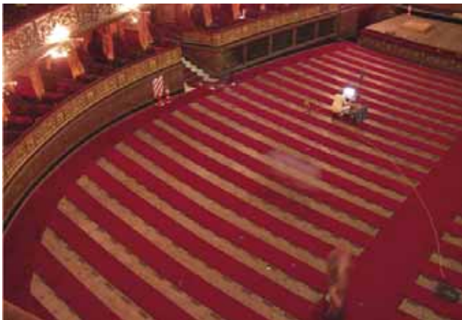
Figura 6. Medición luego del retiro de las butacas de platea.
