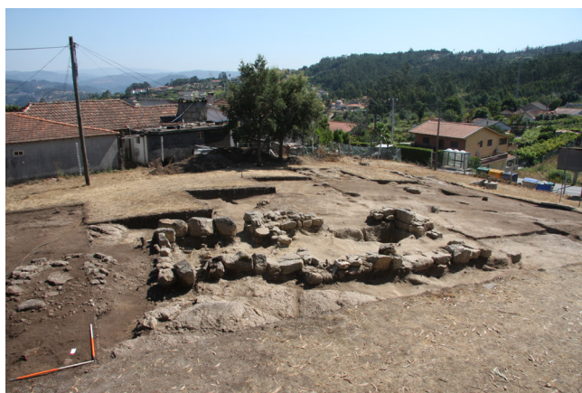
Figura 13: Vista geral da intervenção no sítio de Santo Amaro (MMPNF, 2011).
