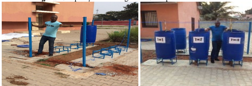
Figura 2: Aquisição e montagem de 6 tanques circulares.
