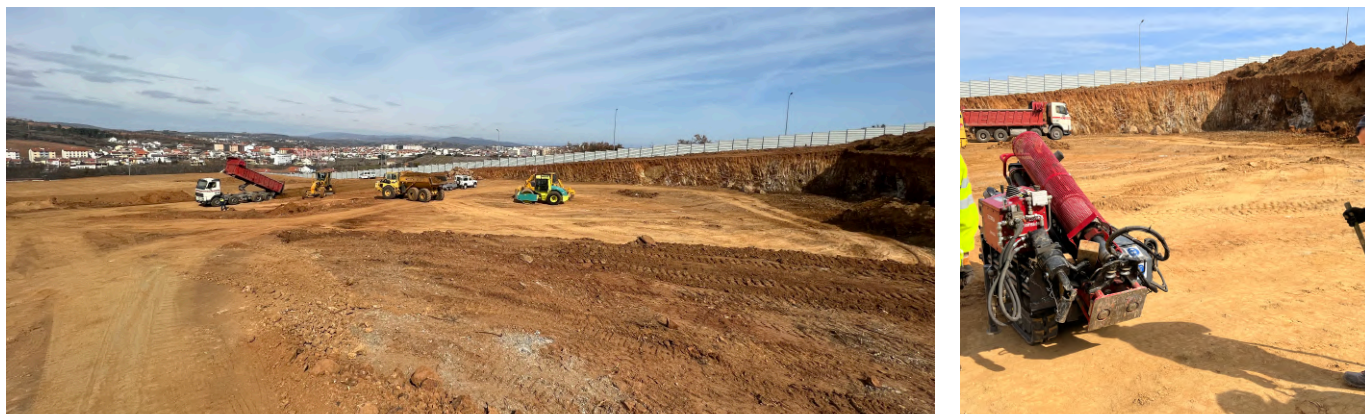
Figura 2 – Local de realização dos ensaios e equipamento de perfuração.
