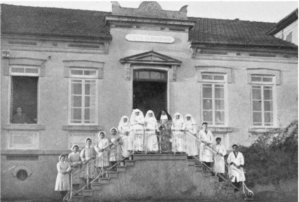
O primitivo pavilhão do novo hospital
