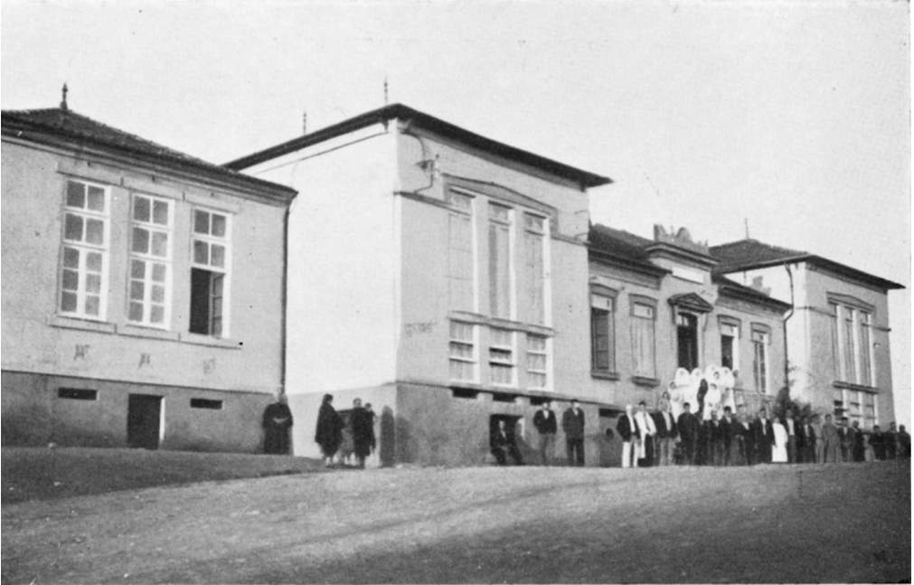
Hospital actual – Pavilhão de homens
