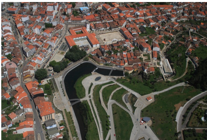
Figura 33. Imagem Aérea da Área após Intervenção.
