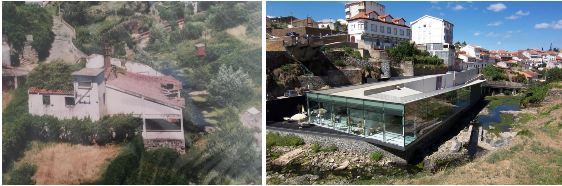
Figura 45. Antiga central hidroelétrica, atual sede do Centro Ciência Viva em Bragança.
