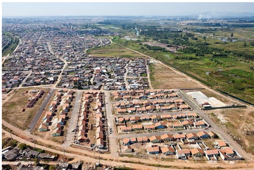
Figura 95. Construção de Unidade Habitacionais- Moradias União Ferroviária.
