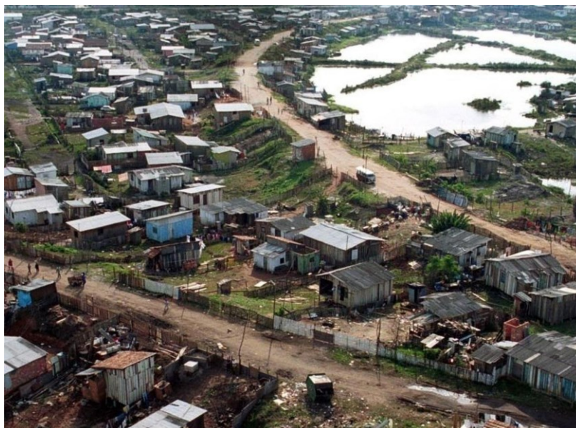
Figura 94. Precariedade das Habitações Antes da Intervenção.
