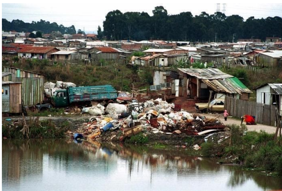
Figura 69. Precariedade Antes da Intervenção.
