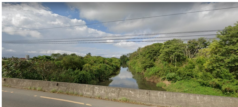
Figura 93. Vista da APP do Rio Iguaçu no limite da área de intervenção. Fonte: Google Street View (2020).
