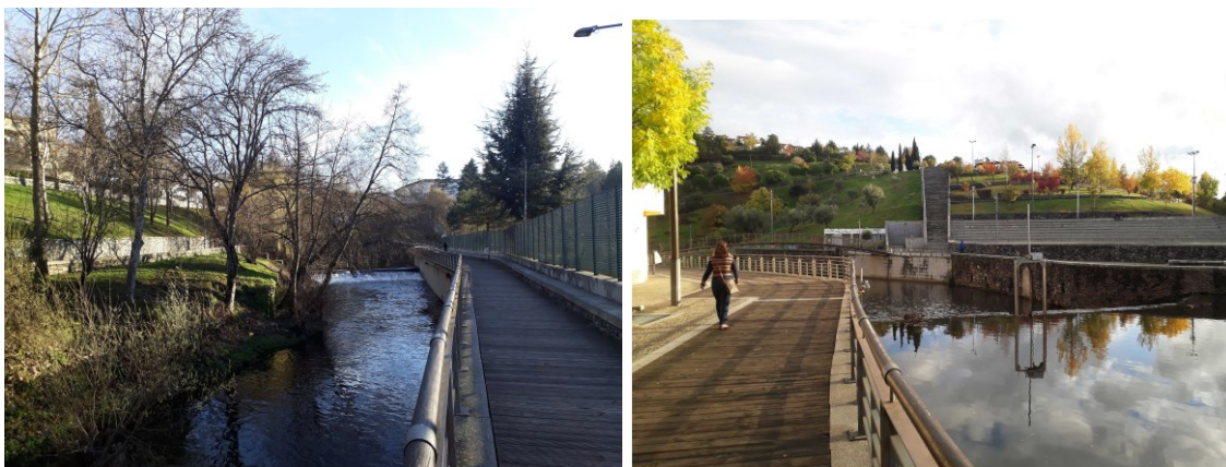
Figura 55. Tratamento das margens do trecho da fase 1 da intervenção.
