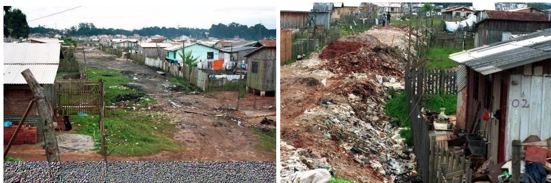
Figura 82. Inexistência de Infraestrutura Antes da Intervenção.
