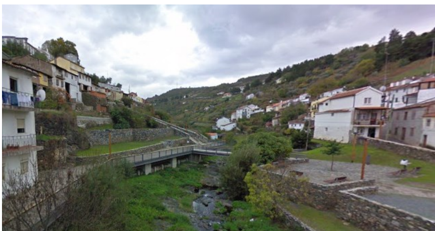
Figura 56. Tratamento das margens do trecho da fase 2 da intervenção.
