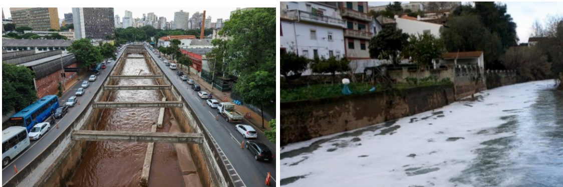
Figura 11. Canalização de córrego e poluição de rio às costas dos terrenos.
