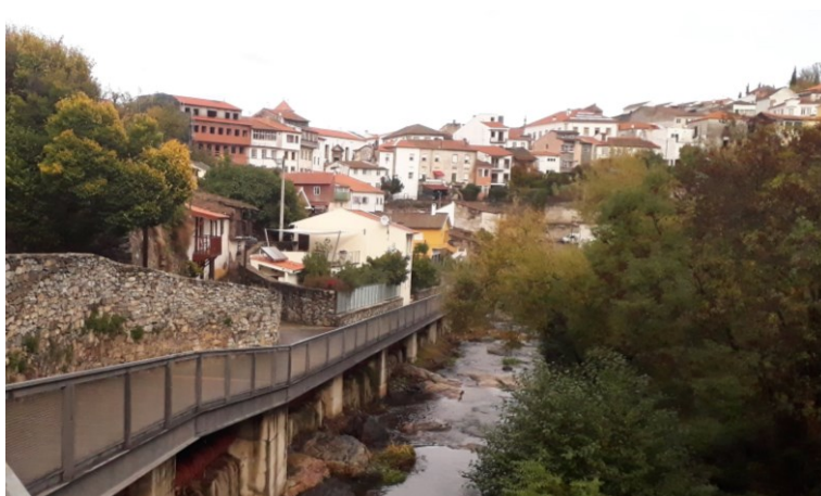
Figura 53. Infraestrutura sob percurso nas margens do rio.
