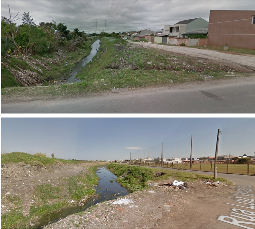
Figura 90. Tratamento das margens do canal aberto da Rua Vicente de Cristo e do canal executado com recursos do Pro-Infra.
