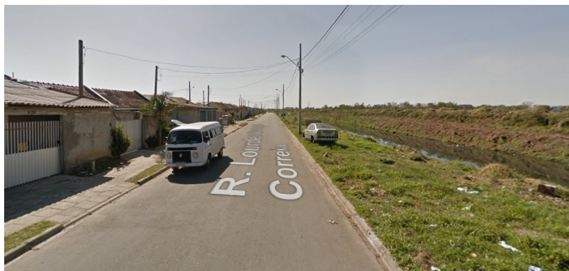
Figura 91. Via, canal de macrodrenagem e dique à direita. Fonte: Google Street View (2018).
