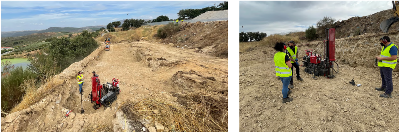
Figura 2 – Local de realização dos ensaios e equipamento de perfuração.
