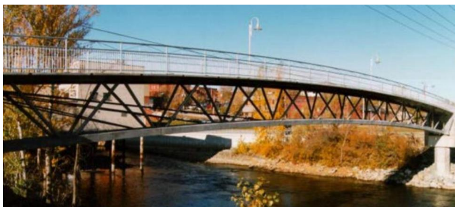
Figura 10 - Passarela de Sherbrooke, Canadá
