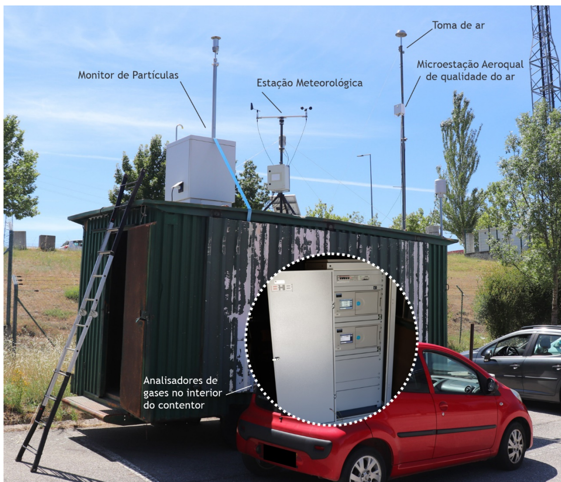
Fig. 36. Apresentação da estrutura instalada para a monitorização da qualidade do ar e parâmetros meteorológicos. Na figura são identificados os principais componentes utilizados no estudo.
