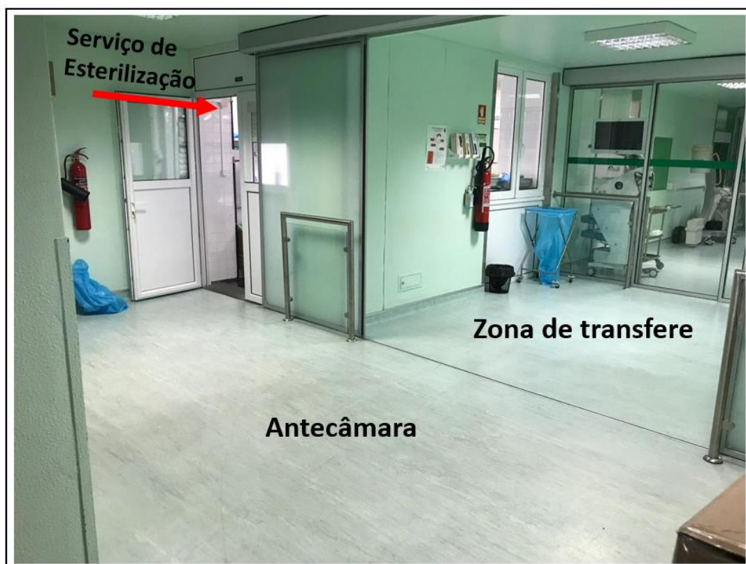
Figura 13. Vista da Antecâmara, zona de transfe com uma das portas de acesso aberta, e porta de acesso a zona do serviço de esterilização.
