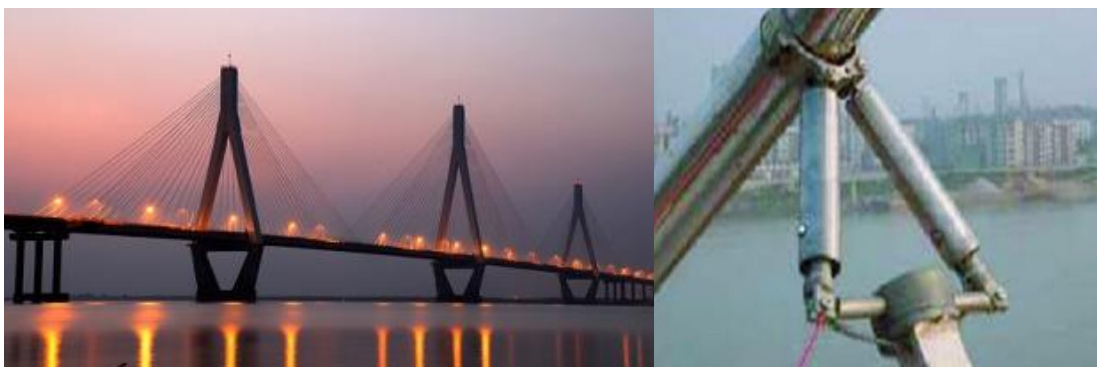
Figura 3.13 – Ponte atirantada sobre o lago Dongting e pormenor de um atuador colocado nos tirantes (Crivellaro, 2008).
