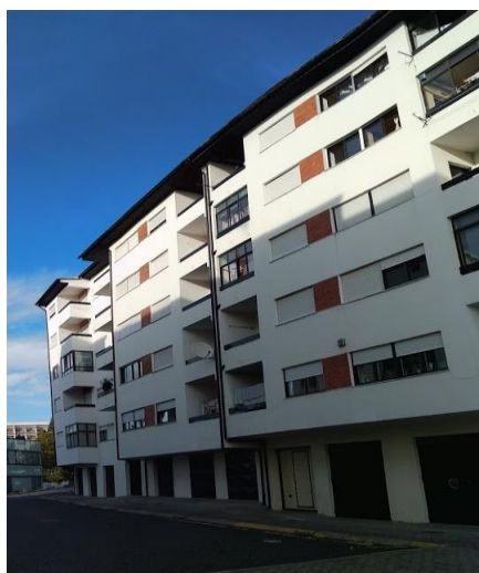
Figura 7: Edifício em análise.
